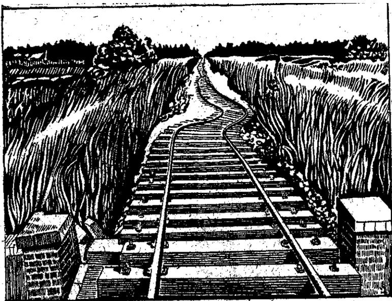
Рис. 68. Сдвиг рельсов при землетрясении.
